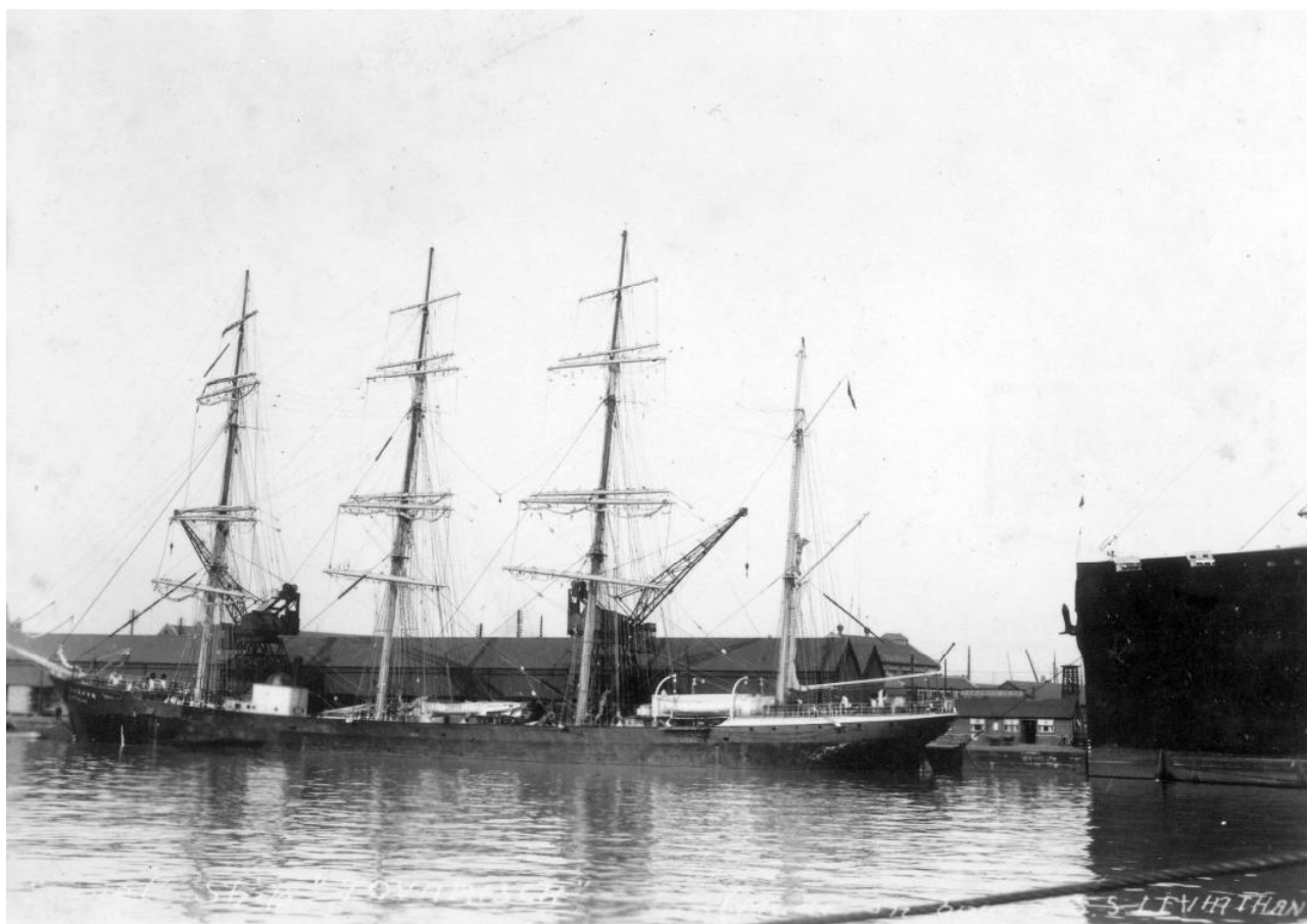
После ремонта. Саутгемптон, 1927
